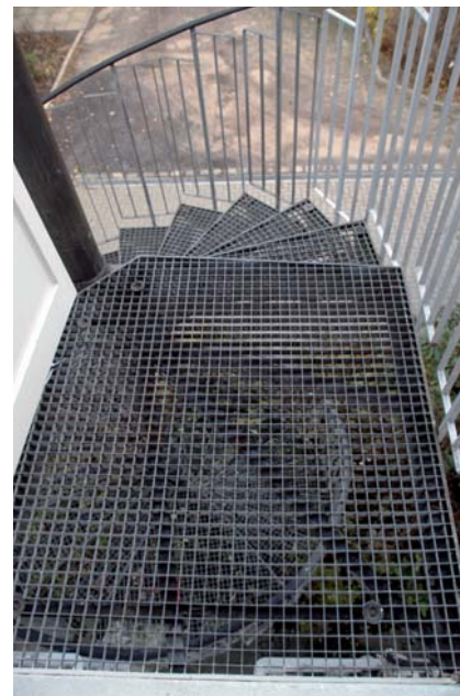
Wendeltreppen – für Rollstuhlfahrer_innen unüberwindbar und auch des Gitter als Untergrund für Menschen mit Unterarmstützen ungünstig.
