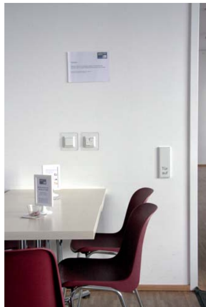
Barrierefreie Lichtschalter, automatische Türöffner und andere Bedienelemente haben eine Höhe von 85 cm.
